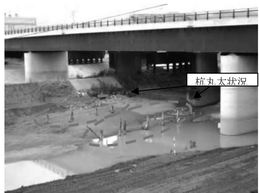
写真-1 掘出し地点の様子
