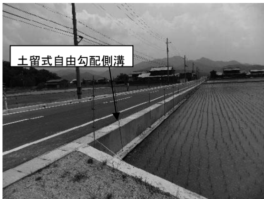
写真-4 土留式自由勾配側溝の状況
