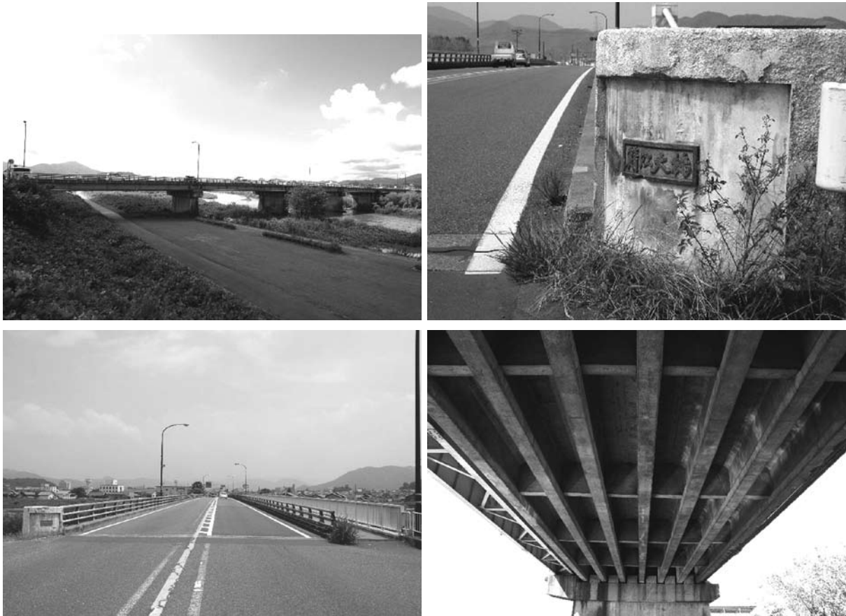
写真-10.4.2 鯖江大橋の現況写真
