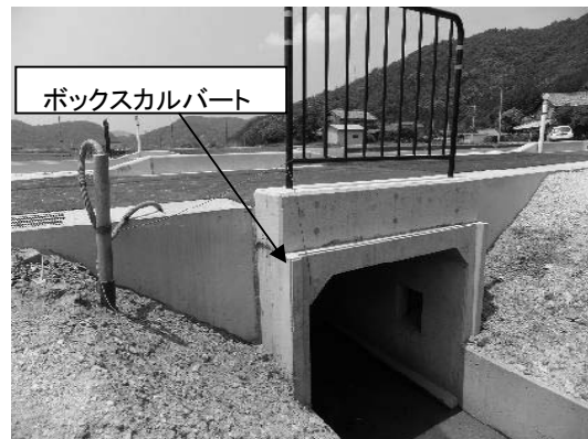
写真-5 ボックスカルバートの状況
