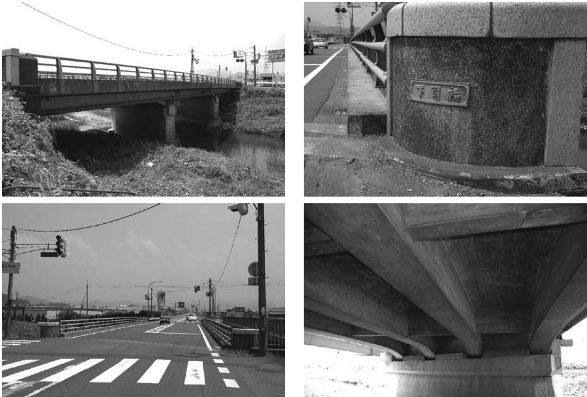
写真-10.4.1 下司橋の現況写真
