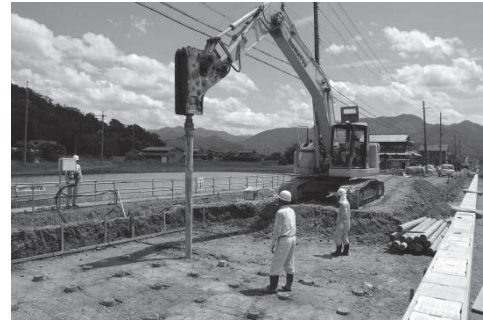
写真3 丸太の現場打設実験
