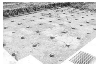
写真-1 丸太杭打設終了状況(A区)
