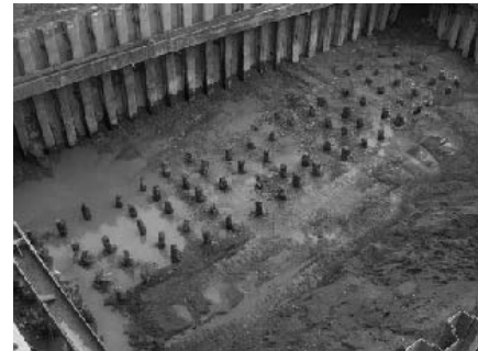
写真2 幸橋第7橋脚の木杭頭部
