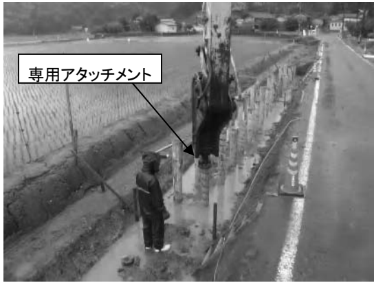
写真-3 専用アタッチメントでの打設
