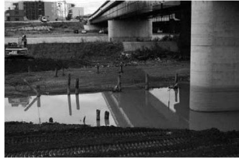
写真1 木田橋下流側の木杭
