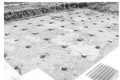
写真-1 丸太杭打設終了状況(A区)
