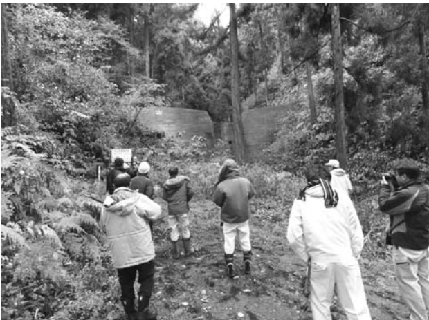
治山ダムの木製残存型枠
